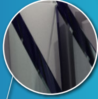
4 + 16 + 4 çift cam uygulama 4+16+4 double glazing application
